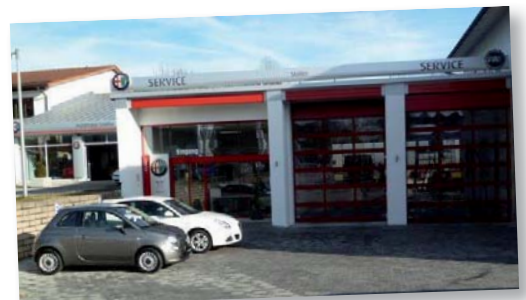
Auch im Autohaus Staller sind die Werkstattgeräte vernetzt
